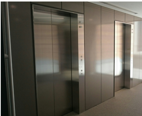
8、9号機 教育施設用エレベーター乗場
