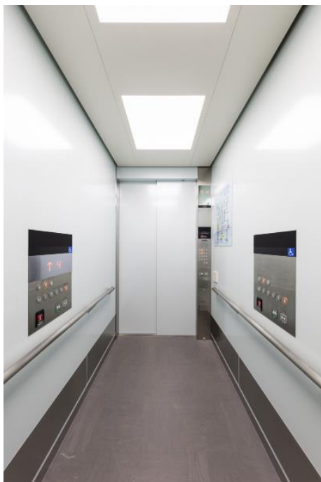
EV2号機 人荷用エレベーター かご内
