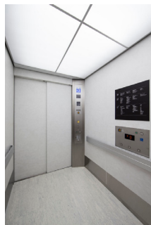
3号機乗用エレベーター かご内
