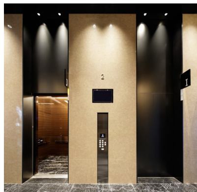
EV12、14号機 2階乗場
