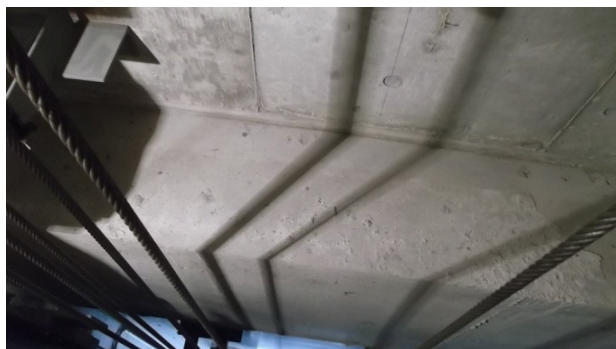
(写真1) 昇降路の出っ張り Projection, Ledge
