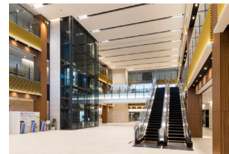
昇降路外観とエスカレーター
