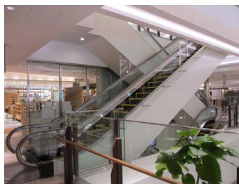
商業棟： J-1~4号機 エスカレーター
