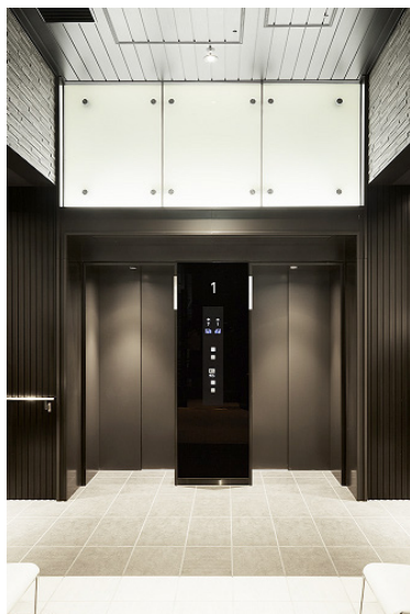
住宅用エレベーター 乗場
