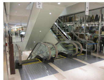
商業棟： I-1~4号機 エスカレーター
