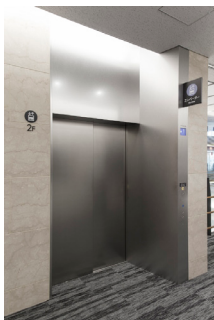
3号機乗用エレベーター 2階乗場
