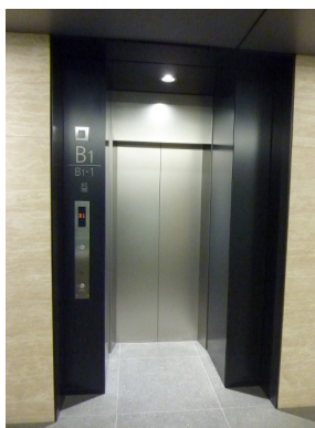
サービス用エレベーター乗場
