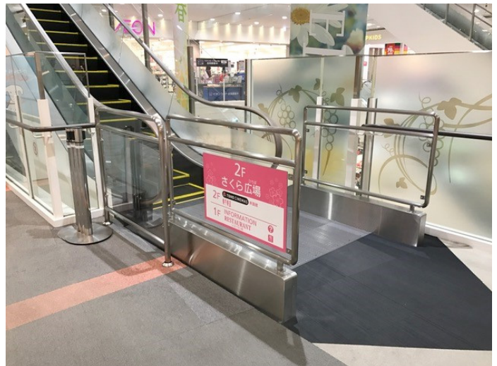
既存エスカレーター（乗降部）
