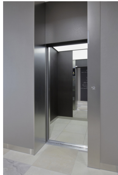
乗用エレベーター 乗場
