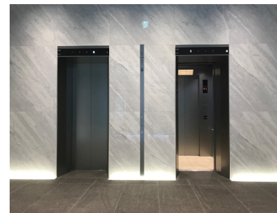
商業用エレベーター乗場
