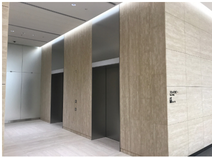
事務所用シャトルエレベーター乗場
