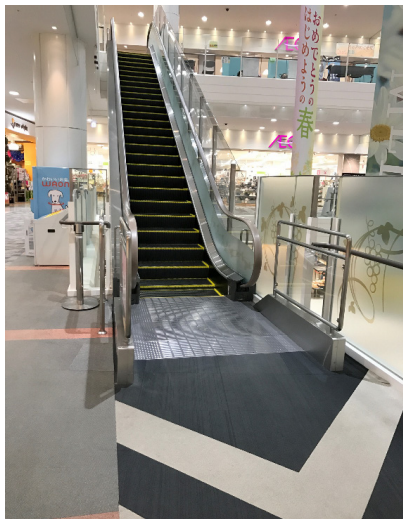
既存エスカレーター（全体）
