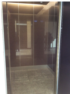
事務所用ローカルエレベーターかご内
