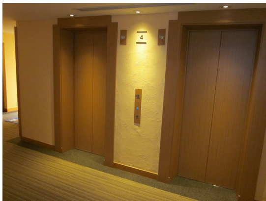
No.3、4号機エレベーター 4階乗場
