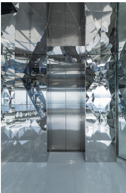
C号機 トップデッキ乗場
