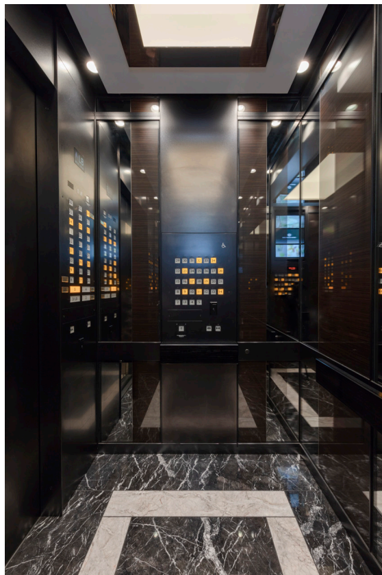
乗用兼車いす仕様エレベーター（側壁側）
