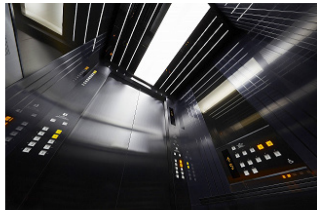
乗用エレベーター かご内
