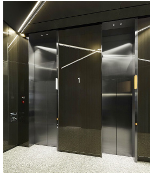
乗用エレベーター 1階乗場
