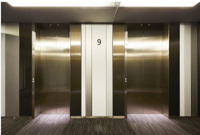
乗用エレベーター 9階乗場
