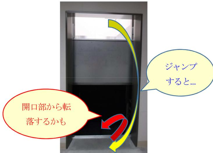
写真4 昇降路への転落イメージ
