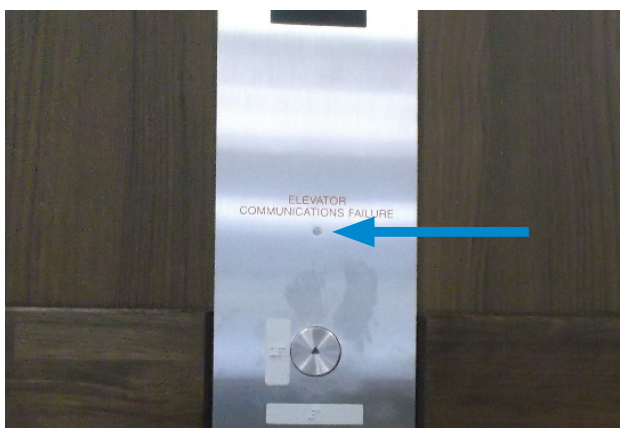
写真3 非常用電話の異常を知らせる赤いランプ
