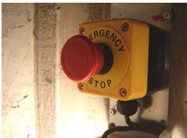
写真1 ピット停止スイッチ
