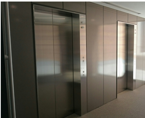
8、9号機 教育施設用エレベーター乗場
