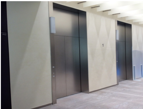
3～7号機 オフィス用エレベーター 1階乗場
