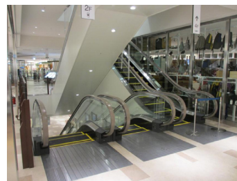
商業棟： I-1~4号機 エスカレーター
