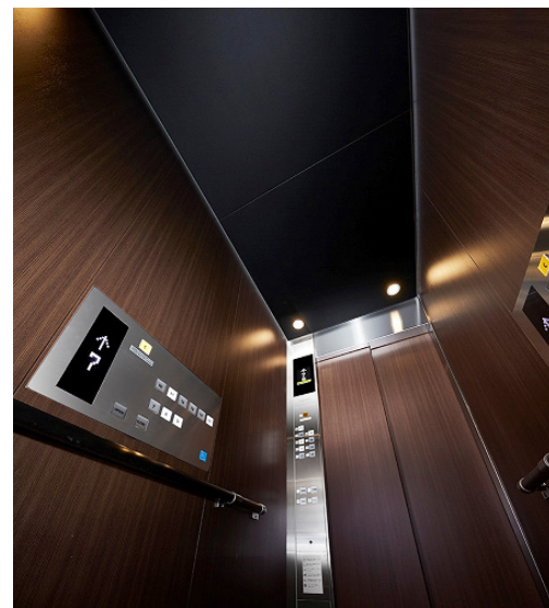
住宅用エレベーター かご内
