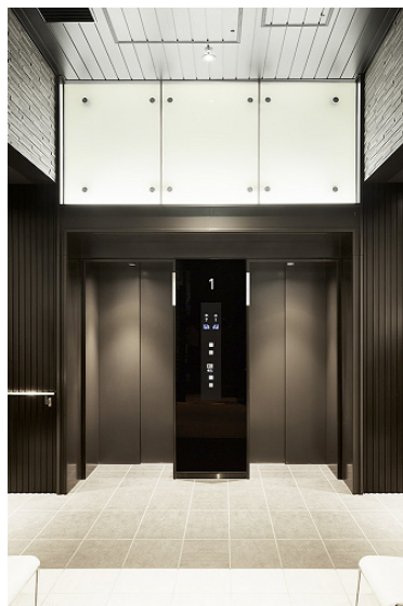
住宅用エレベーター 乗場
