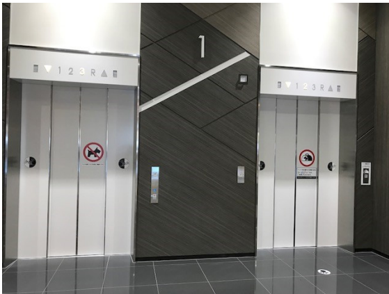
新設エレベーター乗場
