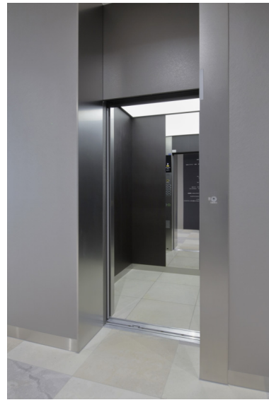
乗用エレベーター 乗場
