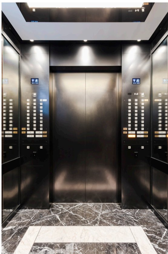
乗用兼車いす仕様エレベーター（出入口側）
