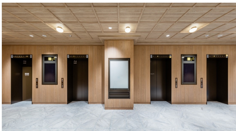
商業用エレベーター 出入口
