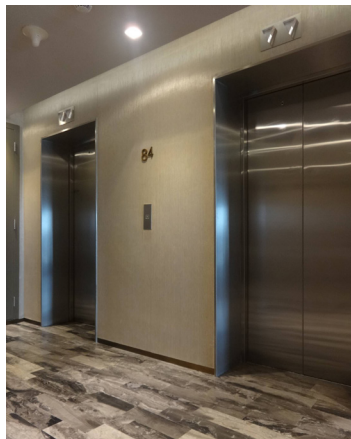
エレベーター乗場(高層用最上階)
