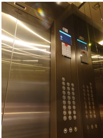
エレベーターかご内 (高層用)
