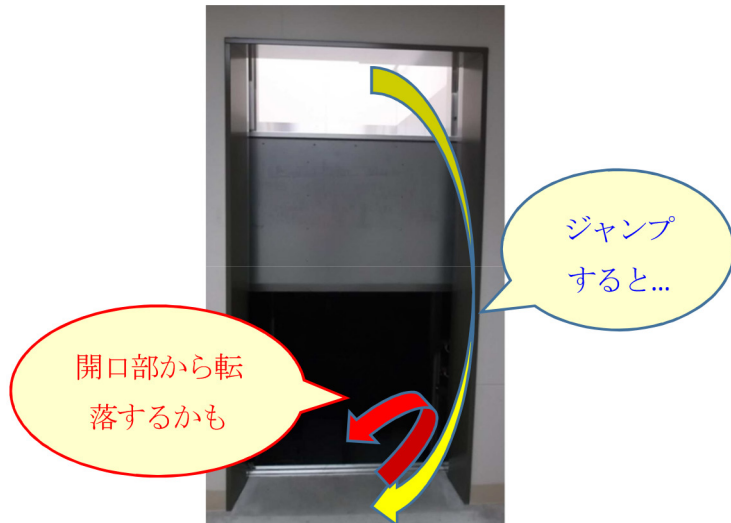
写真4 昇降路への転落イメージ
