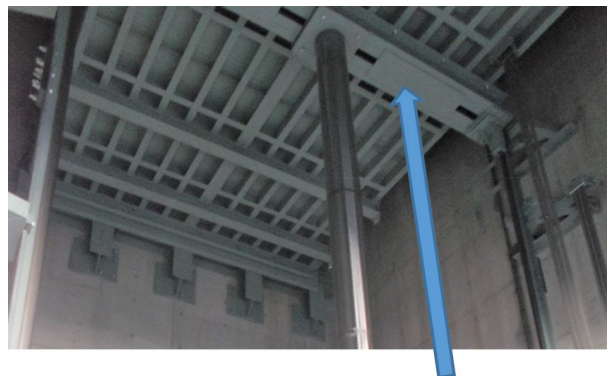
写真9 ボルスター・チャンネル
