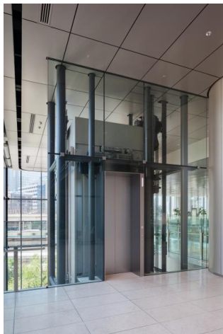
展望用エレベーター 3階乗場
