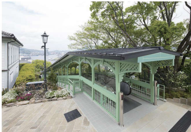
動く歩道外観（1号機）
