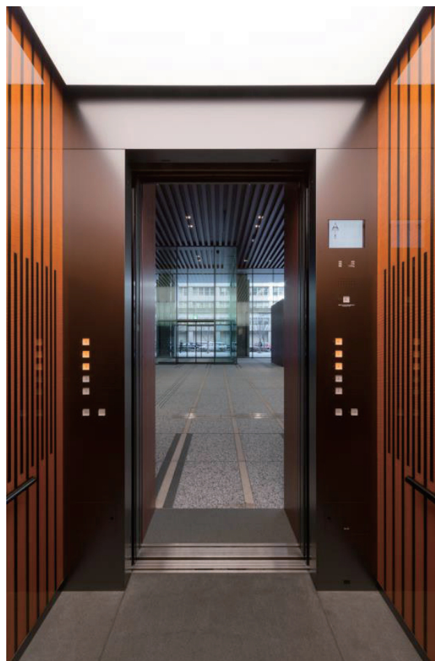
活性化用途客用エレベーターかご内
