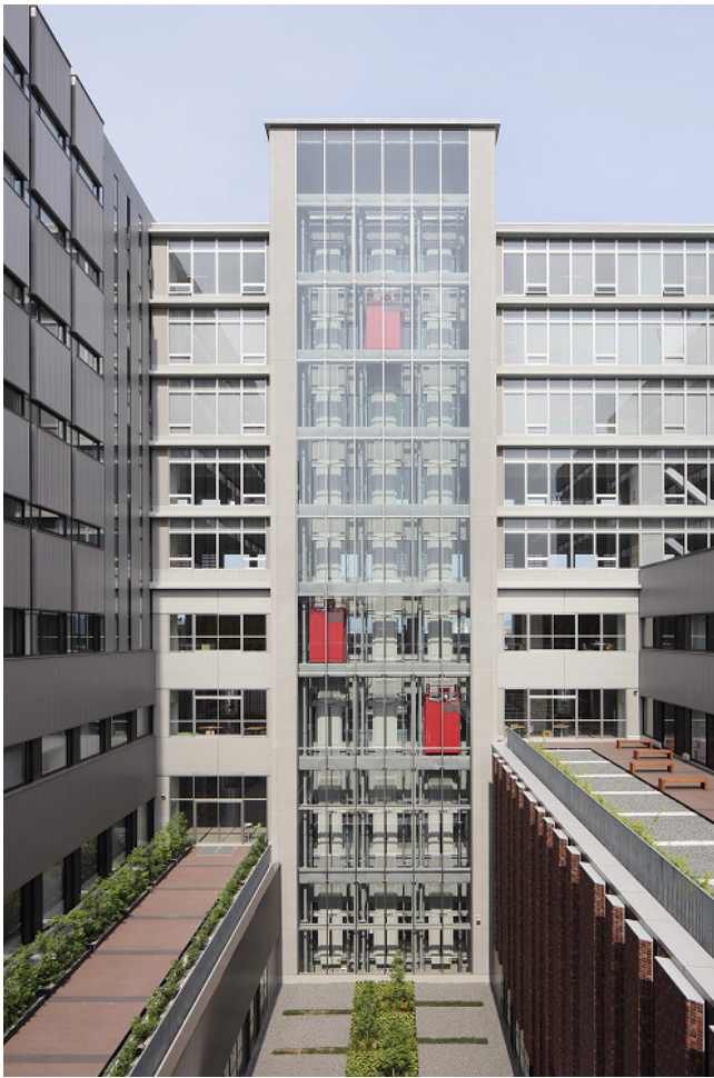
ガラスシャフトエレベーター 外観
