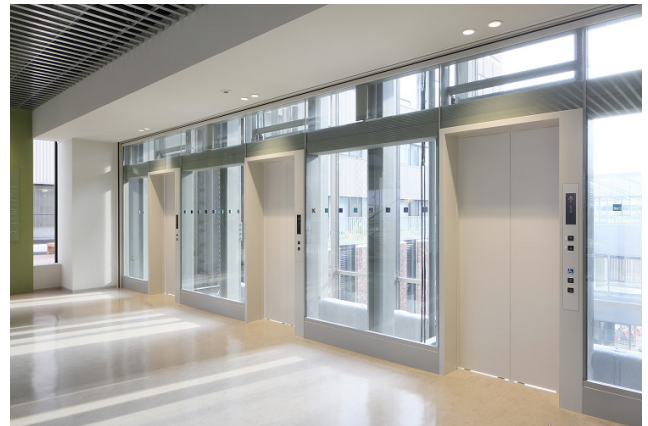
ガラスシャフトエレベーター 乗場
