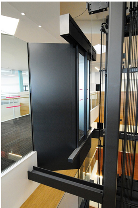
昇降路側へ持ち出された自立タイプの乗場
