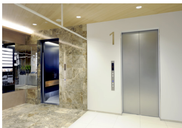
商業用エレベーター SC-1,2 号機 1 階乗場
