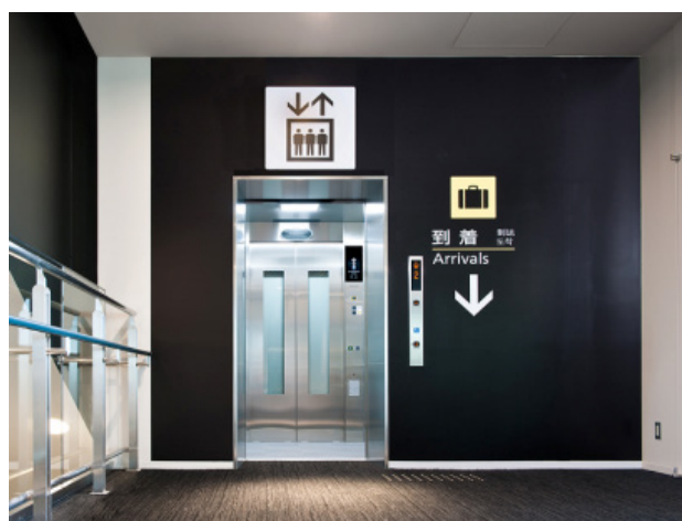
2 階エレベーター 乗場
