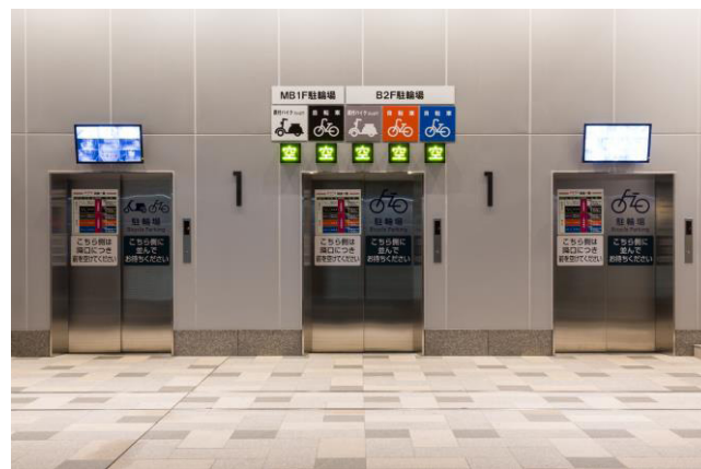
駐輪場用エレベーター乗場
