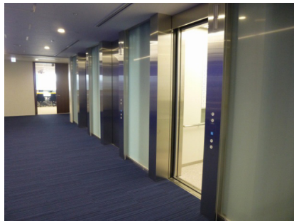
1～3号機 一般階ホール
