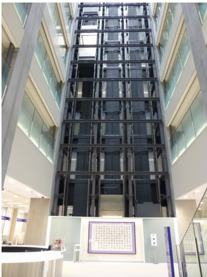
1～3号機 1階吹抜け部から見た昇降路
