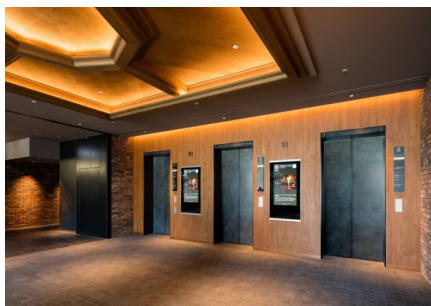
店舗用エレベーター 10階乗場
