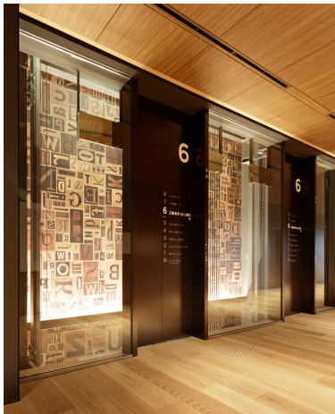
乗用エレベーター乗場
