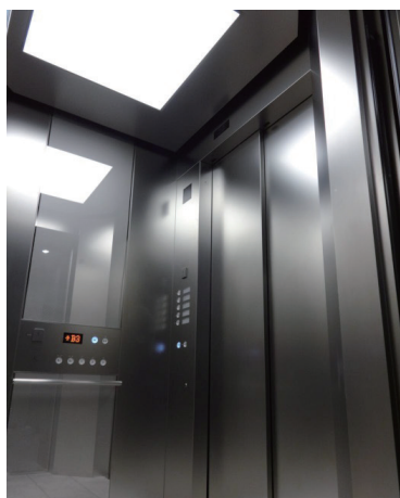
商業棟用エレベーターかご内
