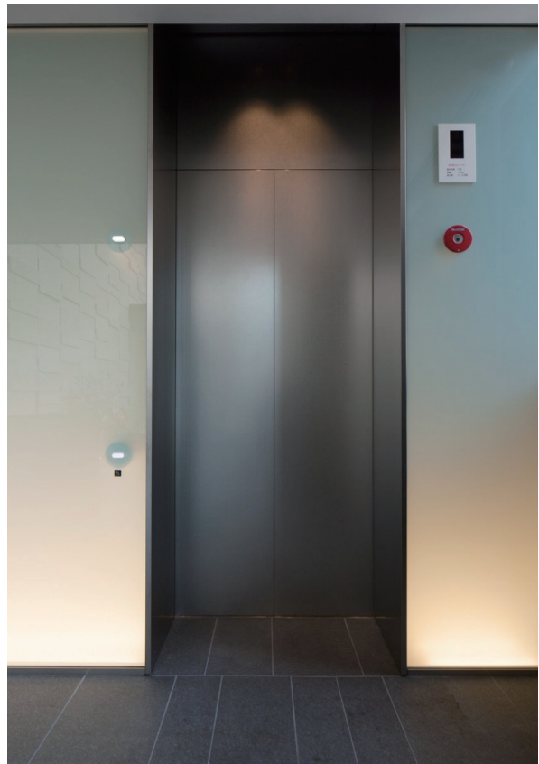
エントランスホールから見たエレベーター乗場 (ガラス壁からホールランタン、乗場押しボタンの光が浮かび上がるよう演出されている)
