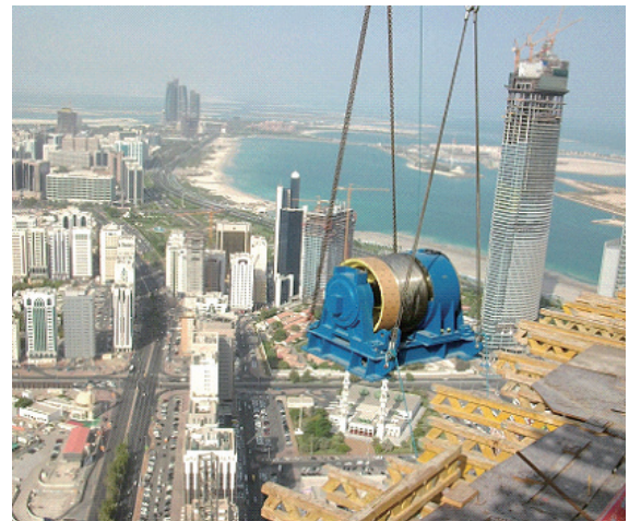
エレベーター巻上機 搬入風景
