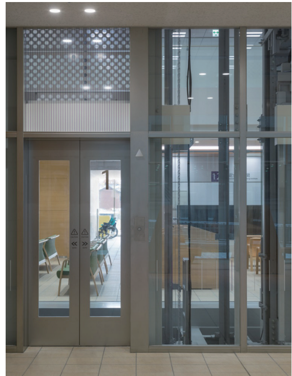
エレベーター乗場
