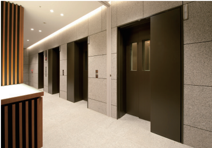
住宅用（1～4号機）乗場
