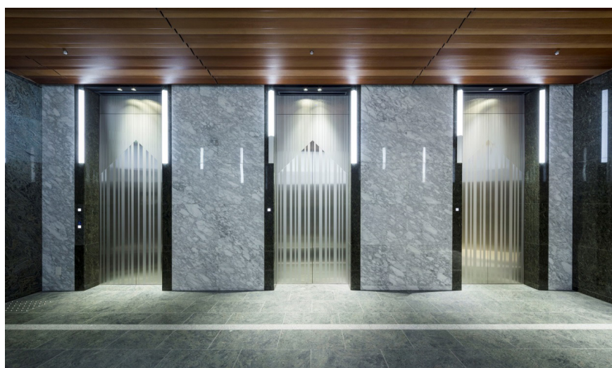
EV-1 ～ 6 号機 乗用エレベーター B1 階乗場
