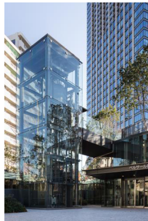
EV-26 号機 乗用エレベーター 外観
