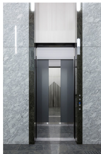
EV-1 ～ 6 号機 乗用エレベーター 1 階乗場
