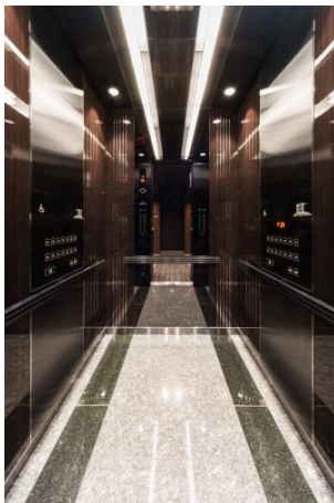
EV-21 号機 乗用エレベーター かご内
