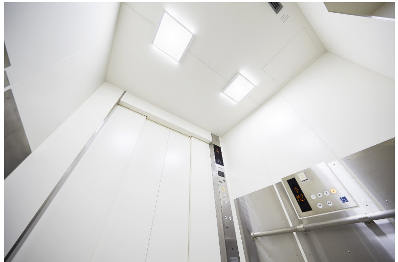
エレベーター1、2号機 かご内
