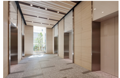
事務所用 乗用エレベーター 1階乗場
