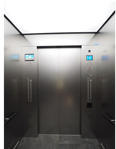
EV13号機 かご内
