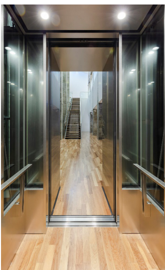
乗用エレベーター かご室正面
