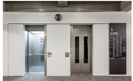
西側 エレベーター 6階乗場
