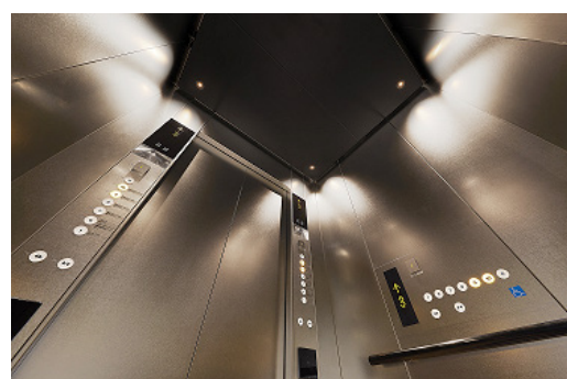
エレベーターEV3～EV5号機 かご内
