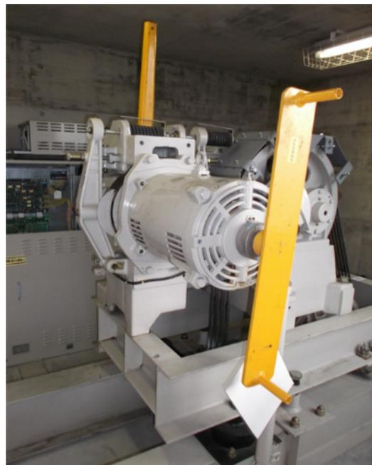
写真4 ブレーキ解放用器具を取り付けた状態
