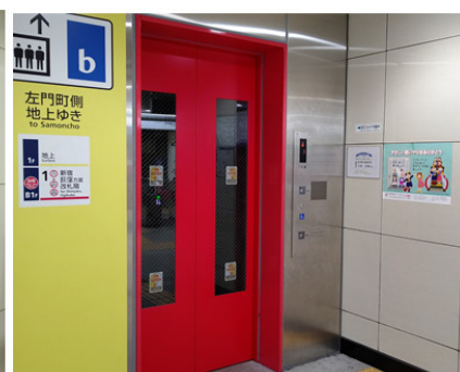
東京地下鉄 四谷三丁目駅
