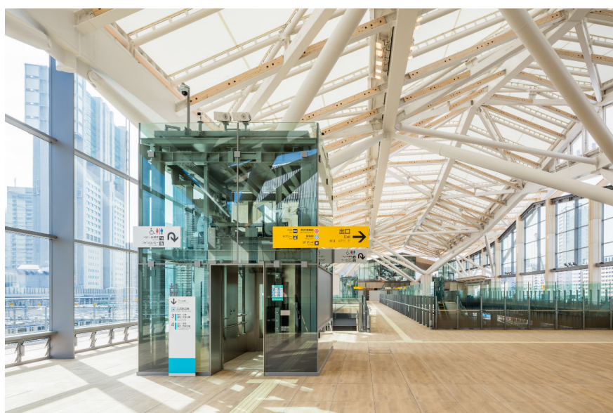
EV-3号機 エレベーター改札階乗場
