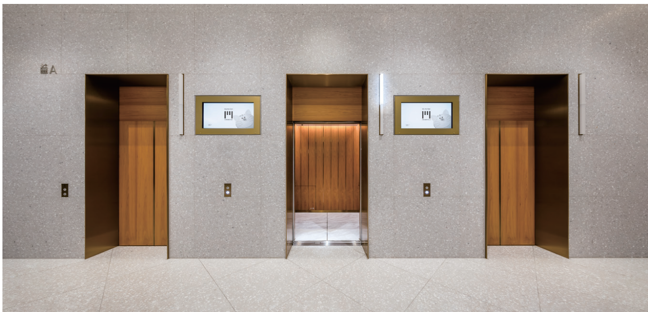
ELV27~29号機 1階乗場
