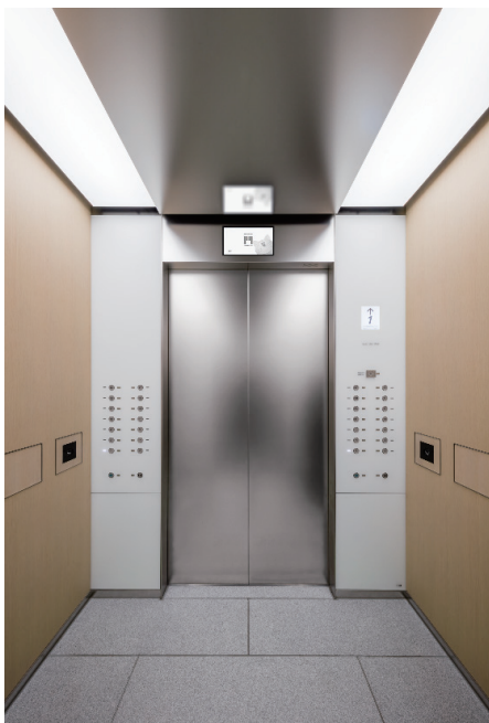
ELV2号機 かご内
