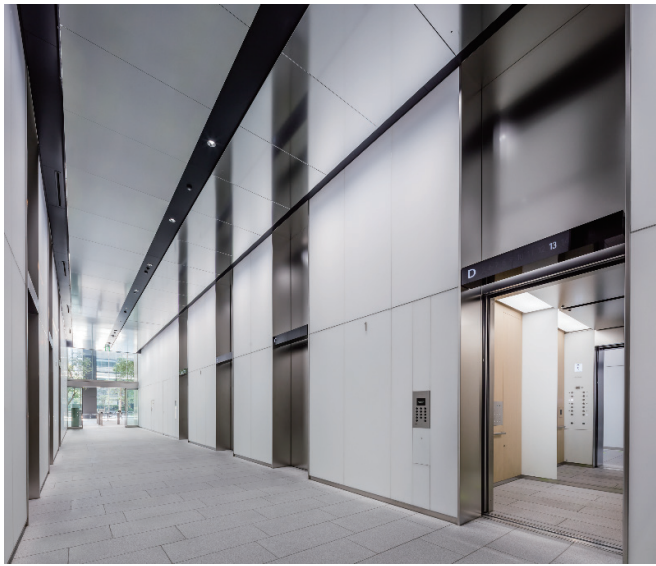
ELV1~8号機 1階乗場
