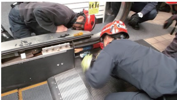
写真2 手すり終端に手（はずす）
