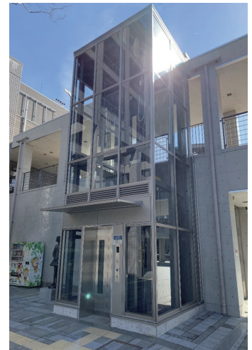
回廊7号機 外観
