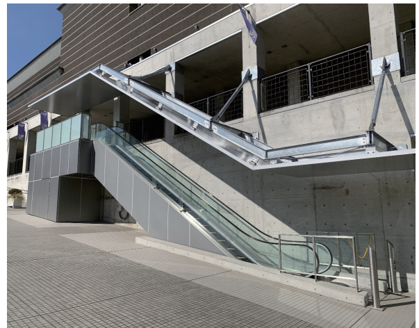
大ホールESC1号機 外観
