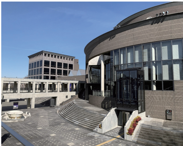
中ホール8号機 外観
