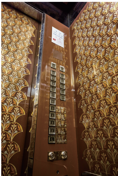
リニューアル前 かが内操作盤
