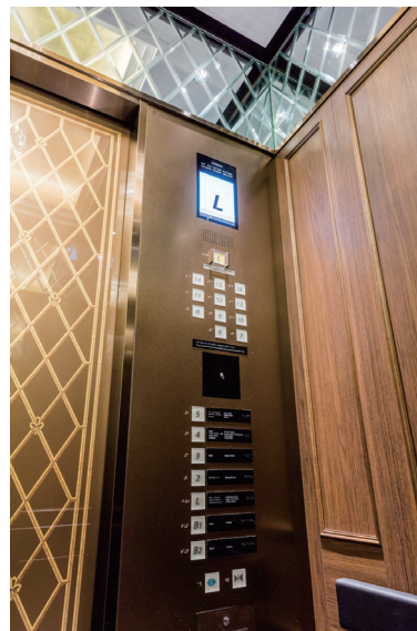
リニューアル後 かが内操作盤
