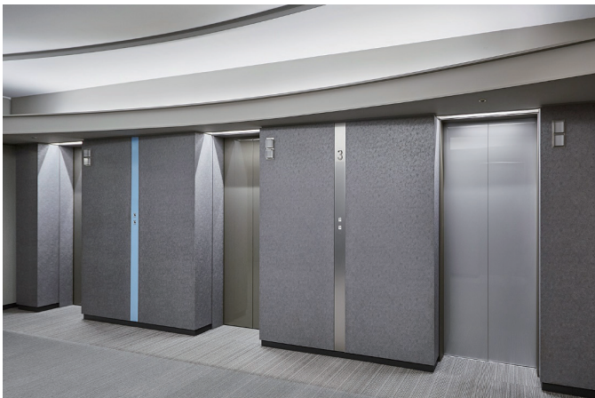
3階乗場 (左側、中央号機：リニューアル前) (右側号機：リニューアル後)
