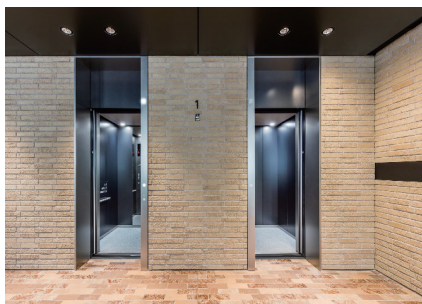
SOHOエレベーター1階乗場
