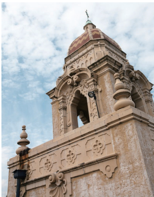
スパニッシュ・バロック様式が漂う エレベーター機械室塔屋
