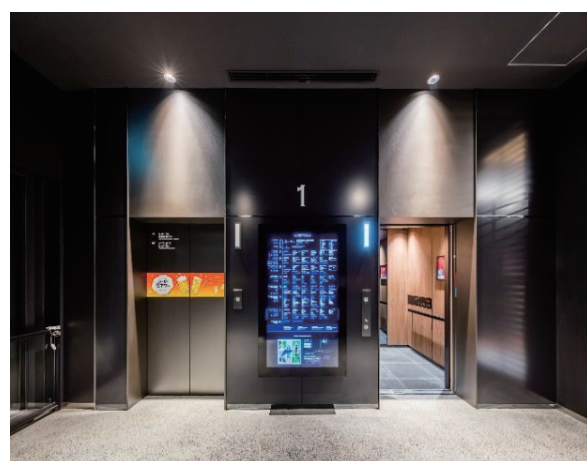
ELV7、8号機 1階エレベーターホール
