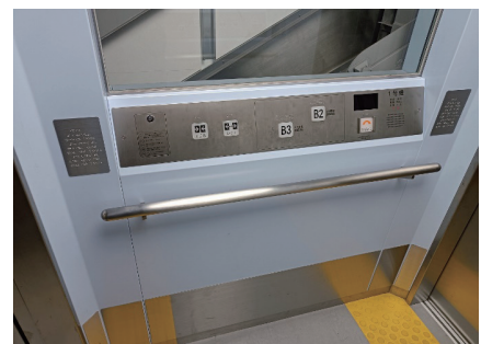
かご内操作盤
