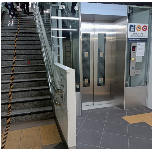
昇降機 B3 階乗場
