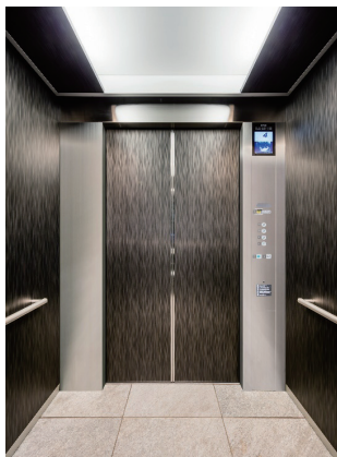
NO.1号機 かが内正面
