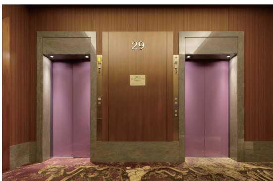
H-3、4号機 29階出入口 (戸閉)
