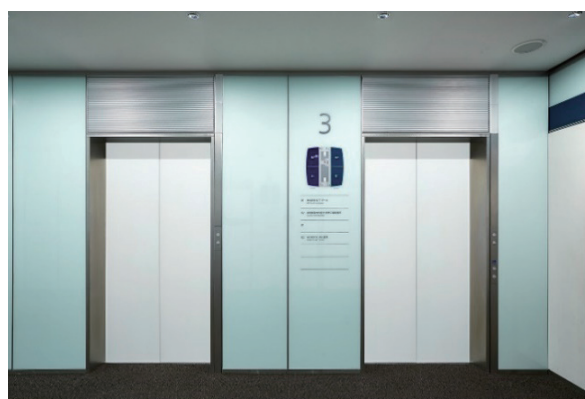
1～16号機 リニューアル後 3階エレベーターホール（正面）
