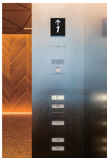
ホテルシャトルエレベーター かご操作盤
