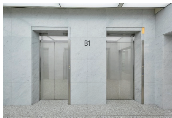
1～16号機 リニューアル後 B1階エレベーターホール（正面）
