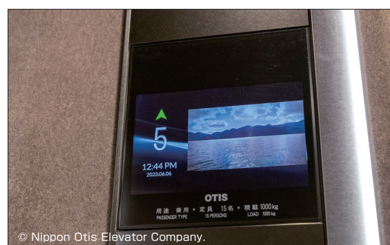
かご操作盤上部 液晶ディスプレイ
