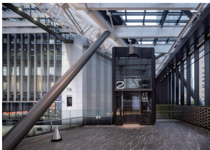
スクエア内エレベーター エレベーターホール
