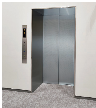
No.9 新設 1階エレベーターホール
