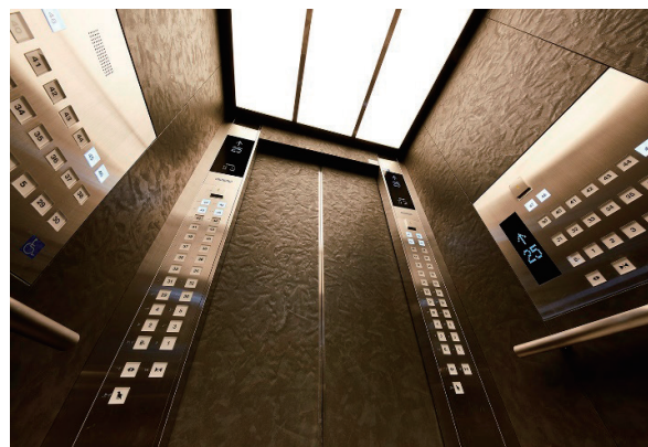
7号機 かご内 (ONE札幌ステーションタワー)
