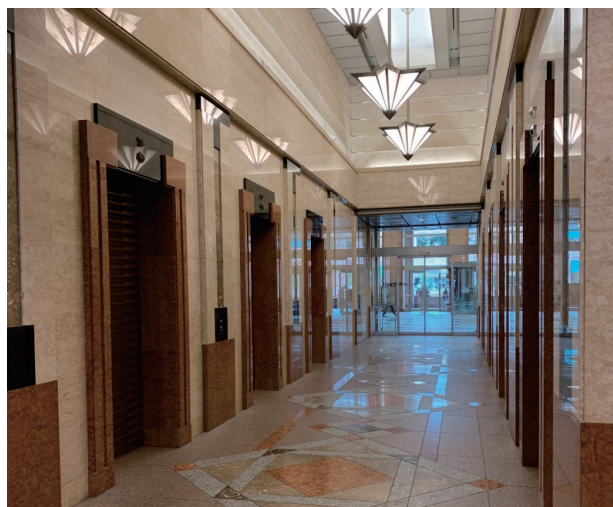
オフィス用エレベーター 1階乗場
