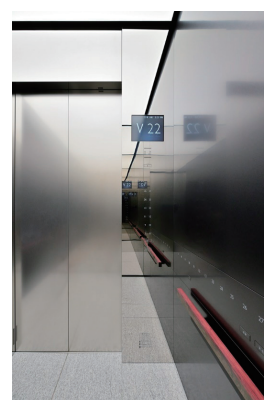
オフィス用エレベーター かご操作盤
