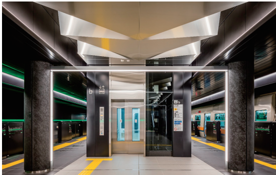
エレベーター1号機
