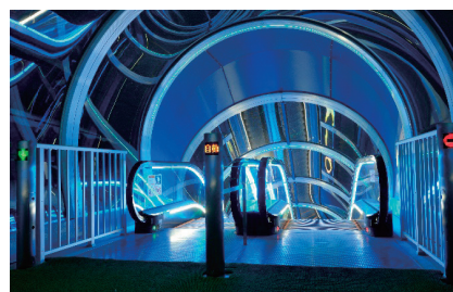
エスカレーター 2-A・B号機 (ライトアップ)
