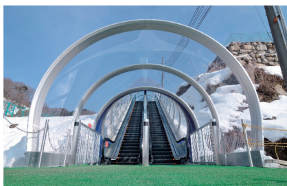
エスカレーター 1-A・B号機
