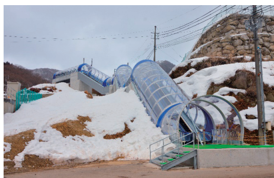
エスカレーター全景
