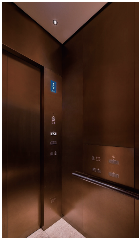
EVH1-2号機 (ホテルシャトル) かご内 主操作盤
