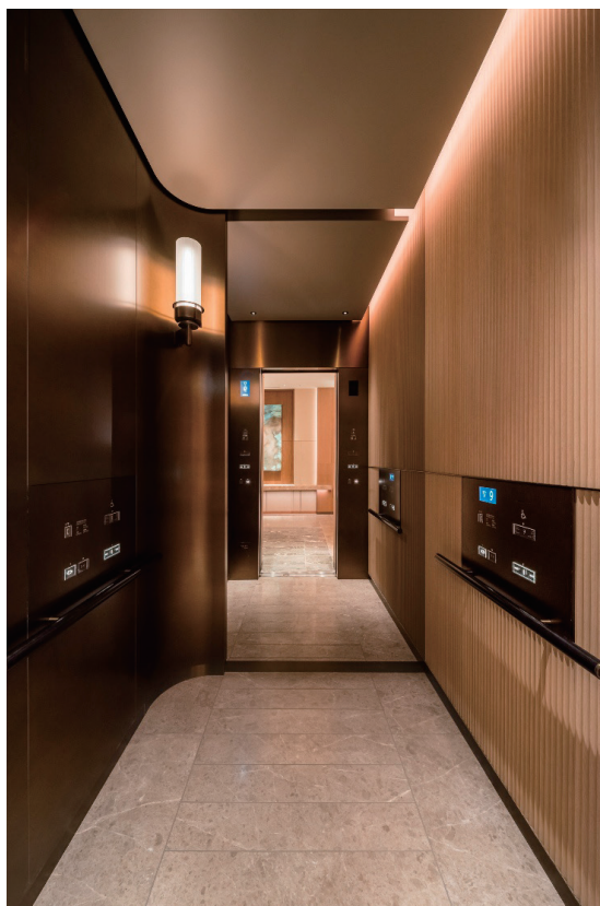
EVH1-2号機 (ホテルシャトル) かご内 側壁木リブパネル
