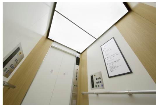
EV2、3号機 乗用エレベーターかご内
