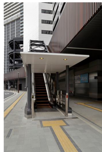
共用部 外部デッキエスカレーター
