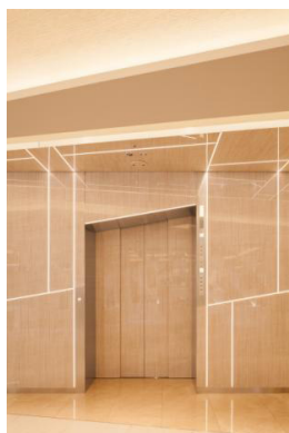
A3号機 店舗用エレベーター 2階乗場
