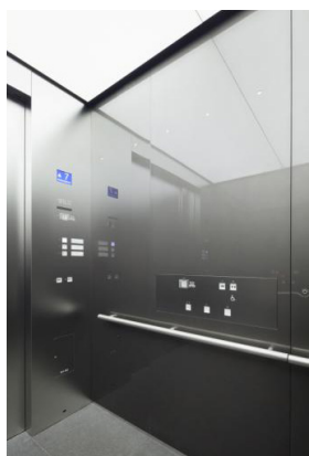
B3号機 オフィス用エレベーター かご内操作盤
