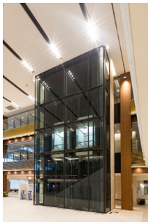
1、2号機乗用エレベーター 昇降路外観
