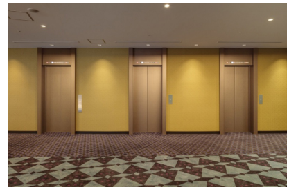
商業施設用 乗用エレベーター 7階乗場
