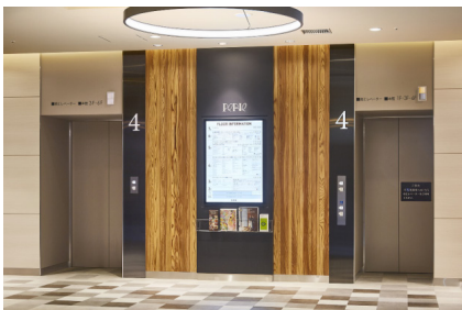
A-1、2号機 エレベーター 乗場
