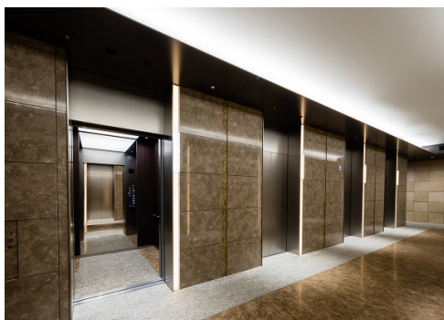
Od-1~8号機 3階エレベーターホール
